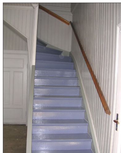
Den nyrenoverade trappuppgången.
