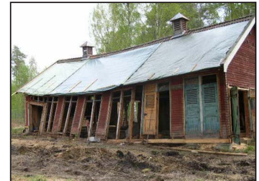
Här ser vi dasslängan under pågående arbete med både tak och väggar.
