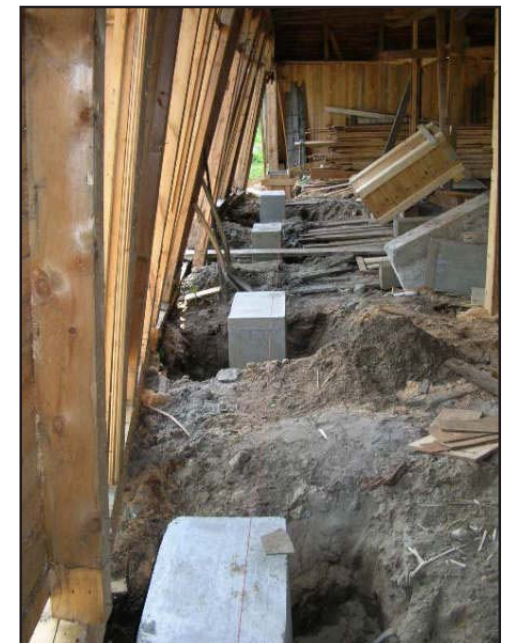
Det var ett drygt arbete med att gräva och gjuta nya plintar för att rätta upp den sneda vägen
