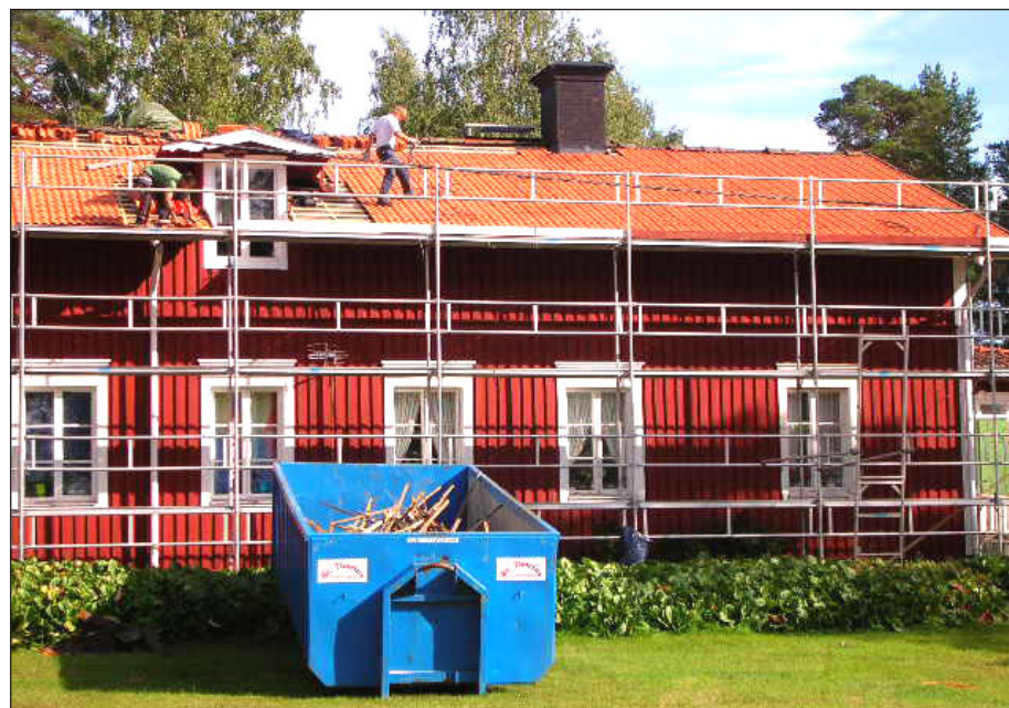
Bilden är från sommaren 2009 under arbetet med takläggningen.
